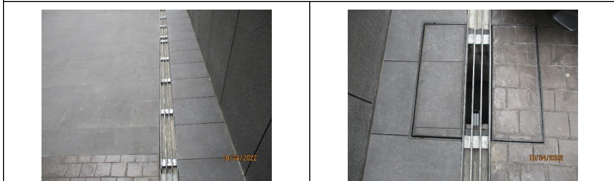
รูปที่ 14 รางระบายน้ำของโครงการ
